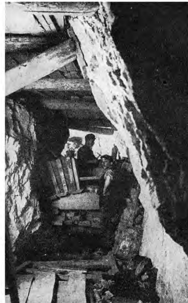
Příbramské doly pod Sv. Horou: Budování zdiva k podchycení závážky.
