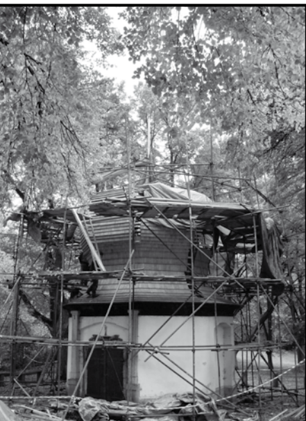
Studánka při nedávné opravě střechy
