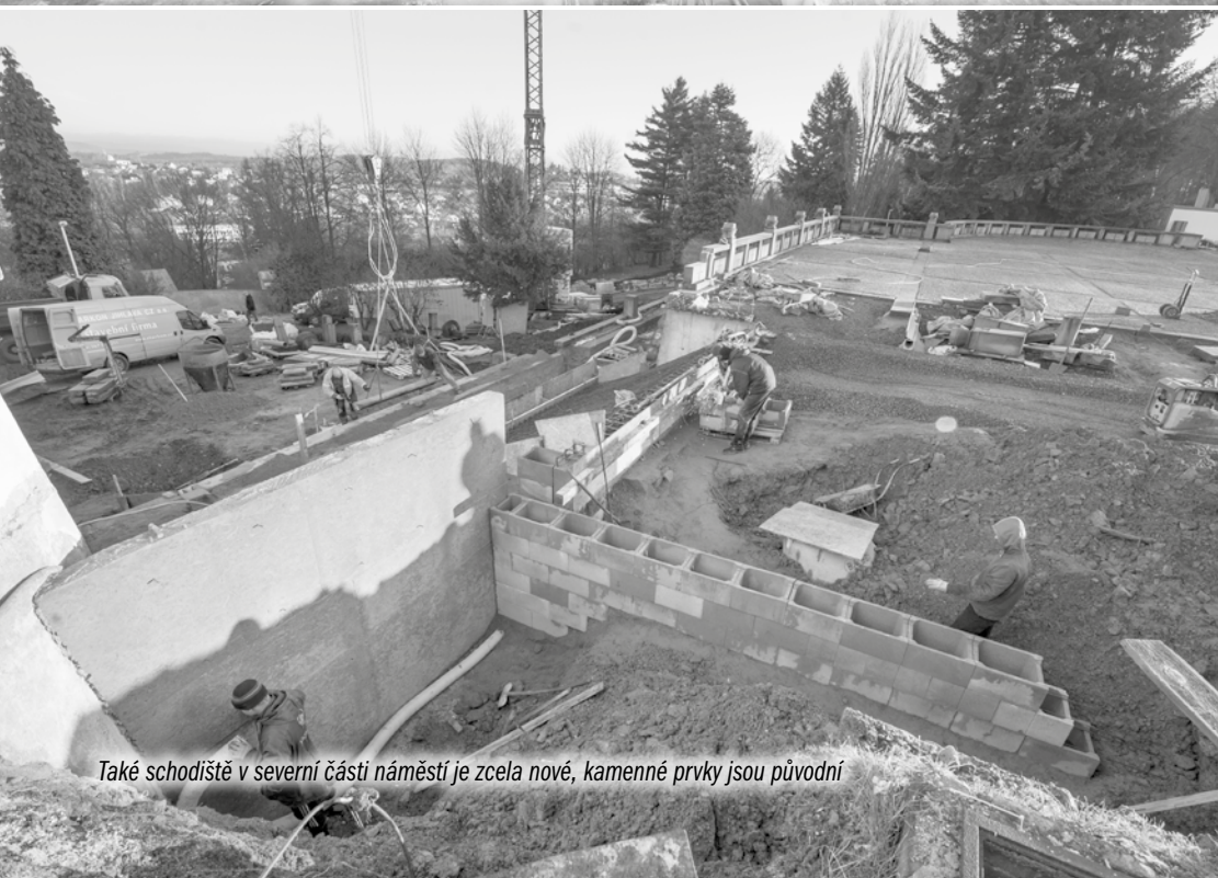
Opěrná zeď náměstí byla vybudována formou betonového monolitu a obložena původním kyklopským kamenem
