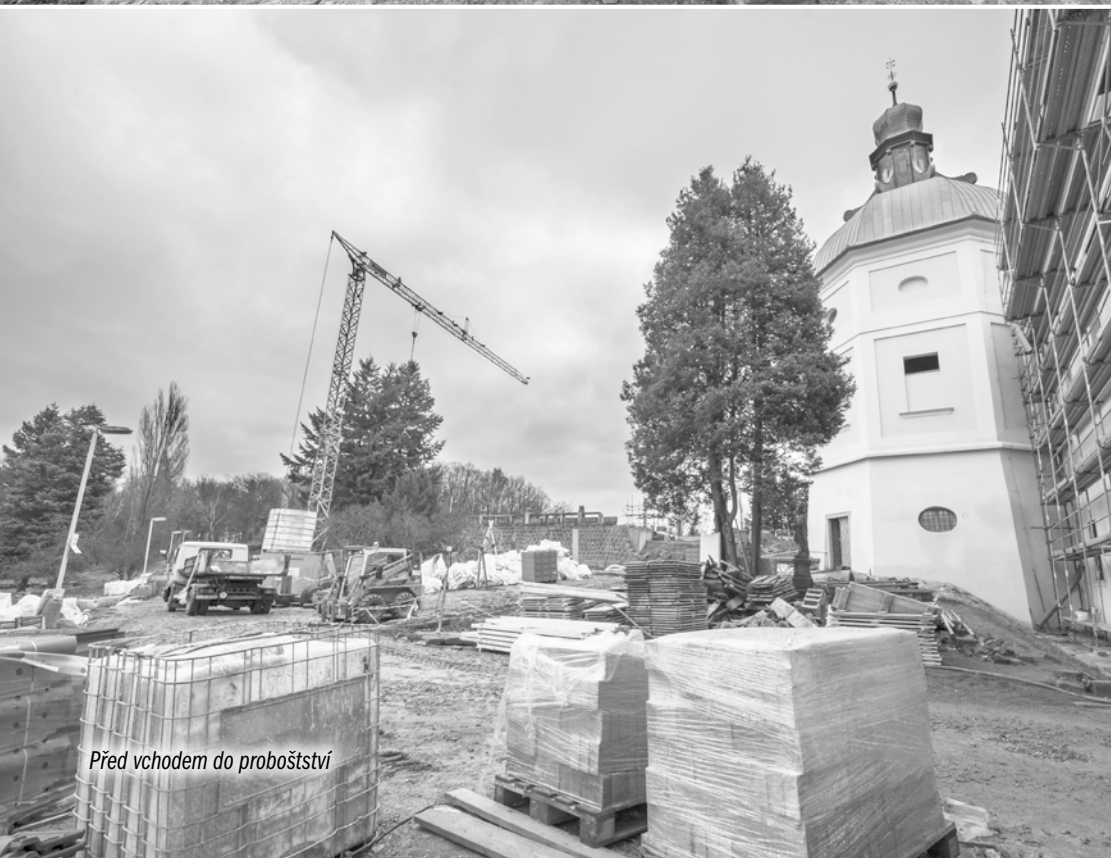
Zde budou opět schody
