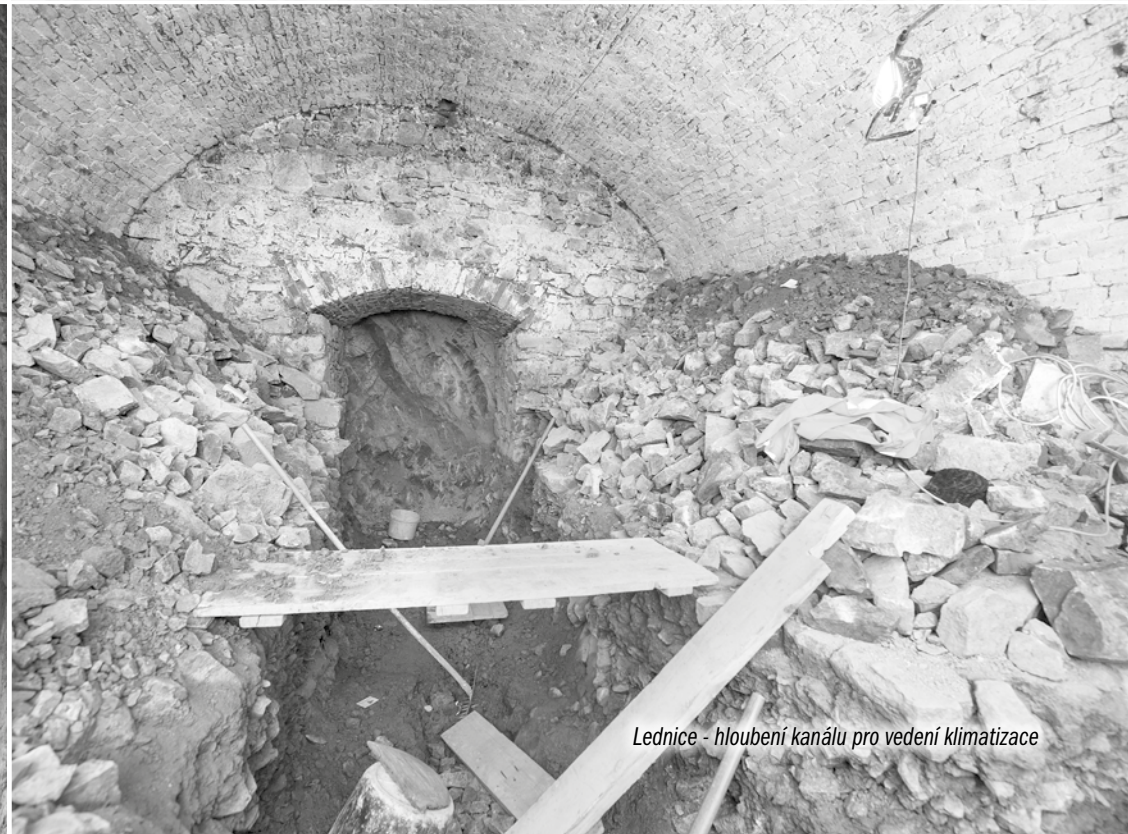
Lednice s odtokovým kanálkem, vybudovaná v nejspodnějším a nejchladnějším sklepě pod východním křídlem rezidence
