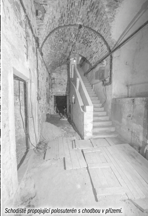
Schodiště, vedoucí do původně zamýšleného vstupu do polosuterénu a do sousedního sklepa, vyústovalo do černé kuchyně.
