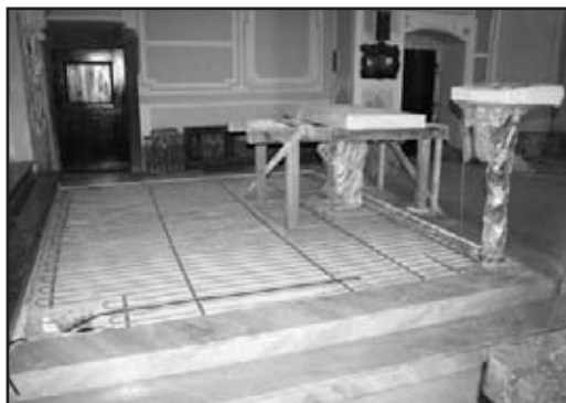
Instalace podlahového topení v bazilice
